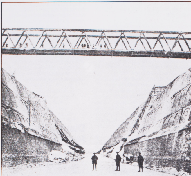
The Tunnellers' Bridge, Canal du Nord
